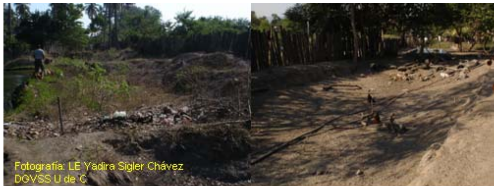
Figura 3.14 Errores de obra y drenaje es estanques de Acuícola La Coyotera.
