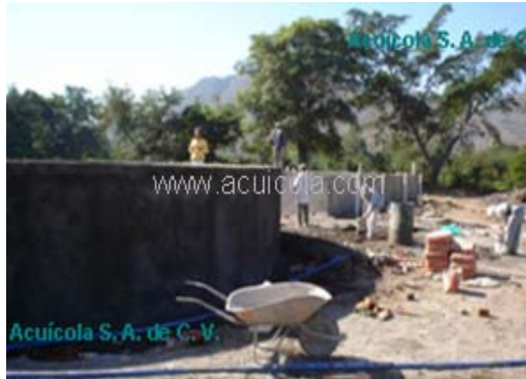
Figura 2.4 Obras en proceso Acuícola SA de CV
