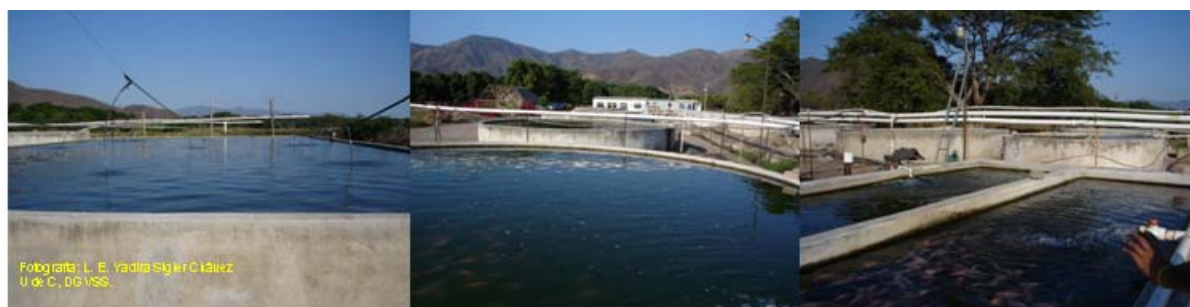
Figura 2.2 Infraestructura de cultivo de Industria Acuícola de Occidente.
