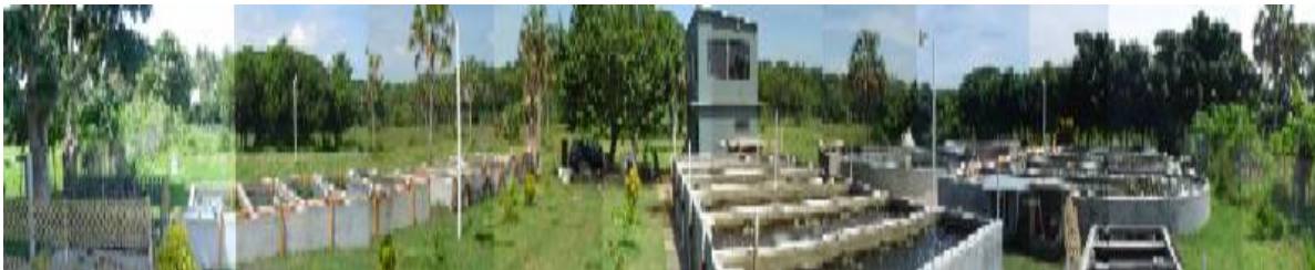
Figura 2.19 Instalaciones Acuicultura de FARO
