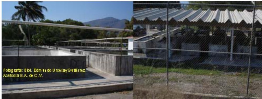
Figura 2.1 Estanques del Centro Acuícola Jala.
